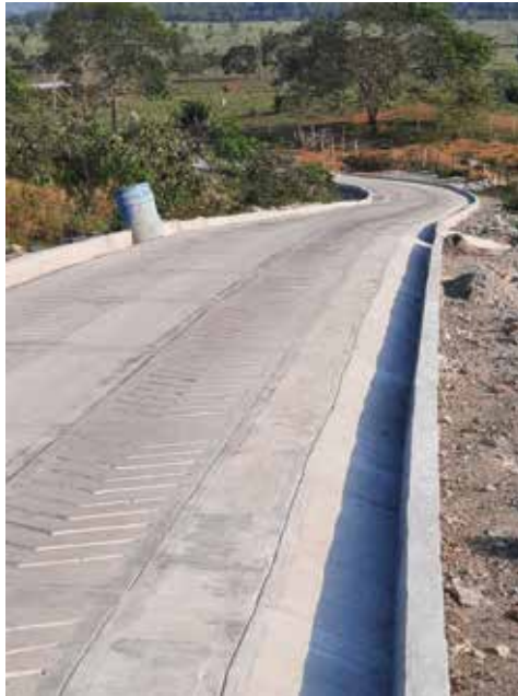
Figura 6: Trazado de la vía de placa-huella
