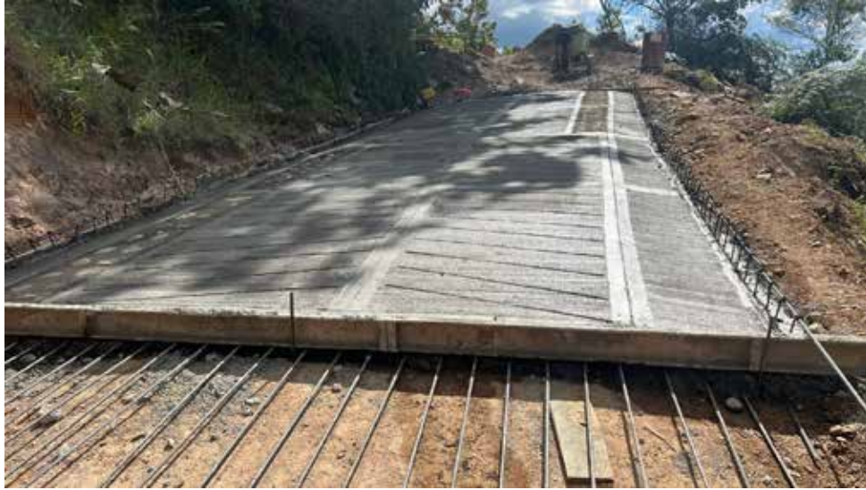
Figura 4: Aspecto de la placa-huella durante su construcción
