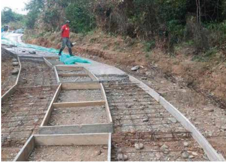
Figura 9: Acero de refuerzo placa huella
