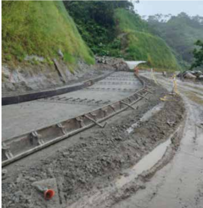
Figura 8: Instalación de formaleta para pavimento
