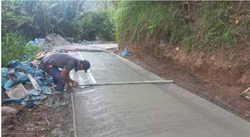
Figura 20: Nivelación placa huella
