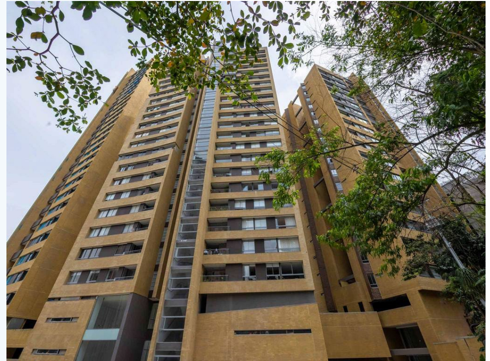
Edificio Font Living
