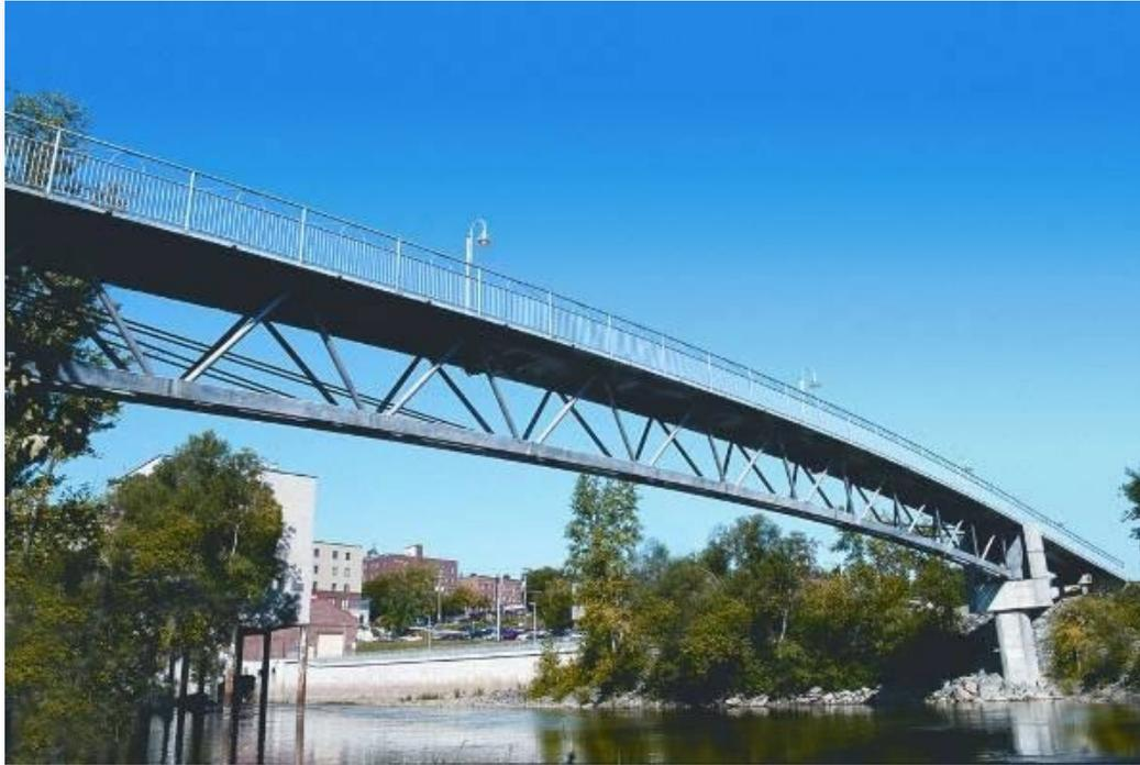
Concreto UHPC empleando cemento, arena, humo de sílice, fibra y aditivos.
