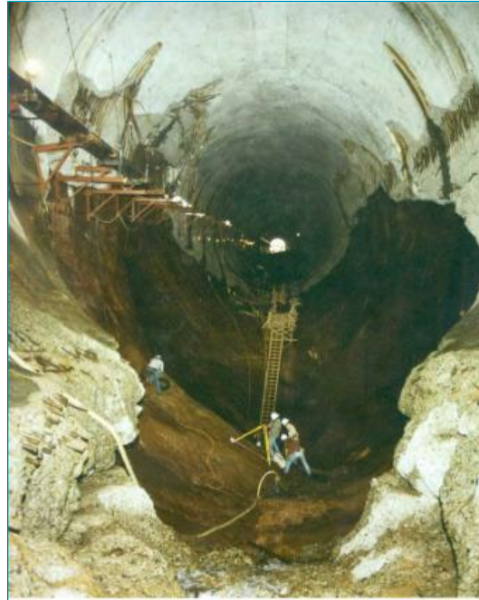
Túnel de vertedero
