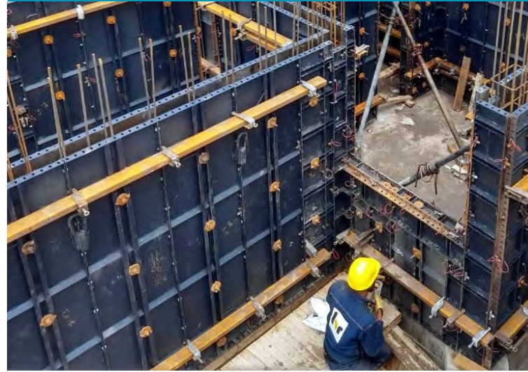
Inspección previa de las formaletas
