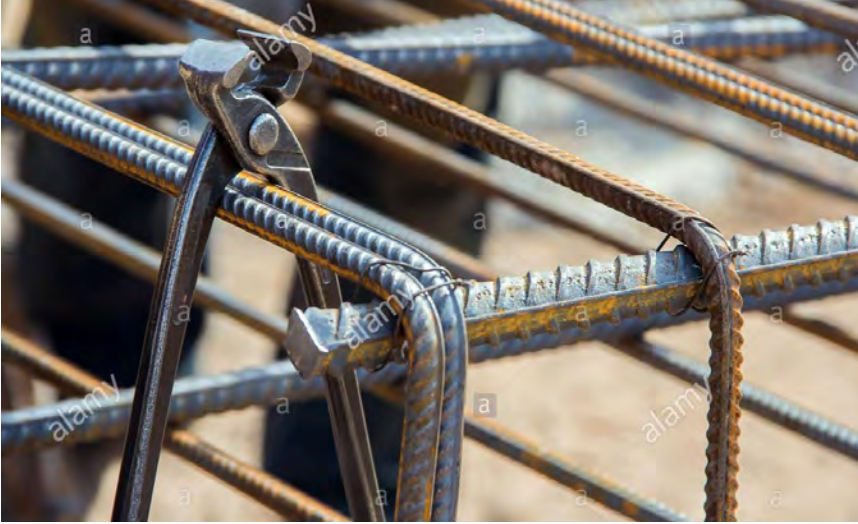
Inspección previa del acero de refuerzo
