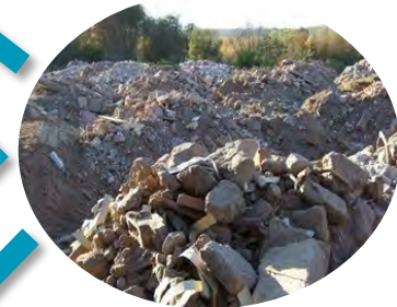
Demolición, selección y reciclaje
