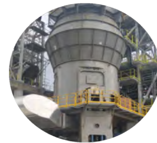
Molienda de Cemento, yeso y adiciones
