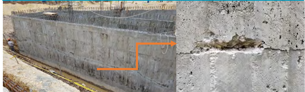
Planeación previa de juntas y sellos impermeabilizantes
