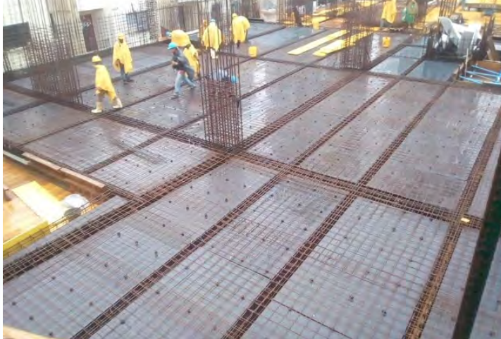
Inspección previa aligeramientos
